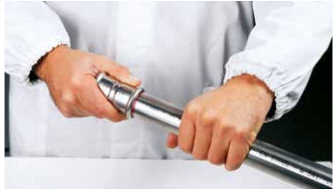
Afbeelding 31 - Inbrengen van de buis in de te persen fitting
