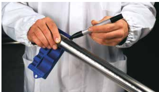
Afbeelding 28 - Ontbreken van de insteekdiepte
